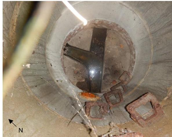
Abbildung 4-3: Schacht nordöstlich des Wiesenwegs mit vermutlich zu sedimentierter Drainage (oberer Zulauf), Straßentwässerung (linker Zulauf) und Ableitung unter der L39 Richtung Wiesenweg (unterer Ablauf)
